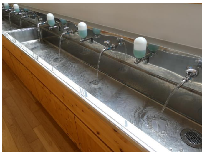
水道管の中の古い水を流しているところです。
